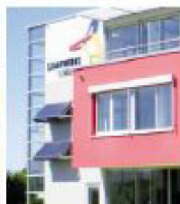
Vorbildlich: Solarthermie und Photovoltaik am Stadtwerkbau. Foto: him
